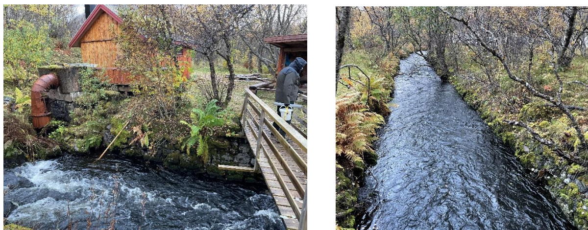
Figur 12. Rester av kraftverket i Fagerhaugelva og kanalisert strekning med sterk homogenisering av elveløp.
