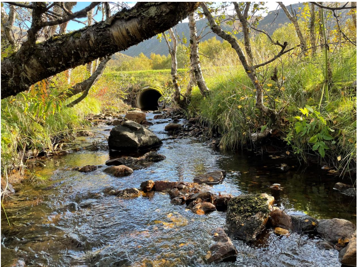
Figur 32 Fiskepassasje ved veikulvert Hundsdalselva utformet som naturlig stryk og bygget av naturstein i 2023.
