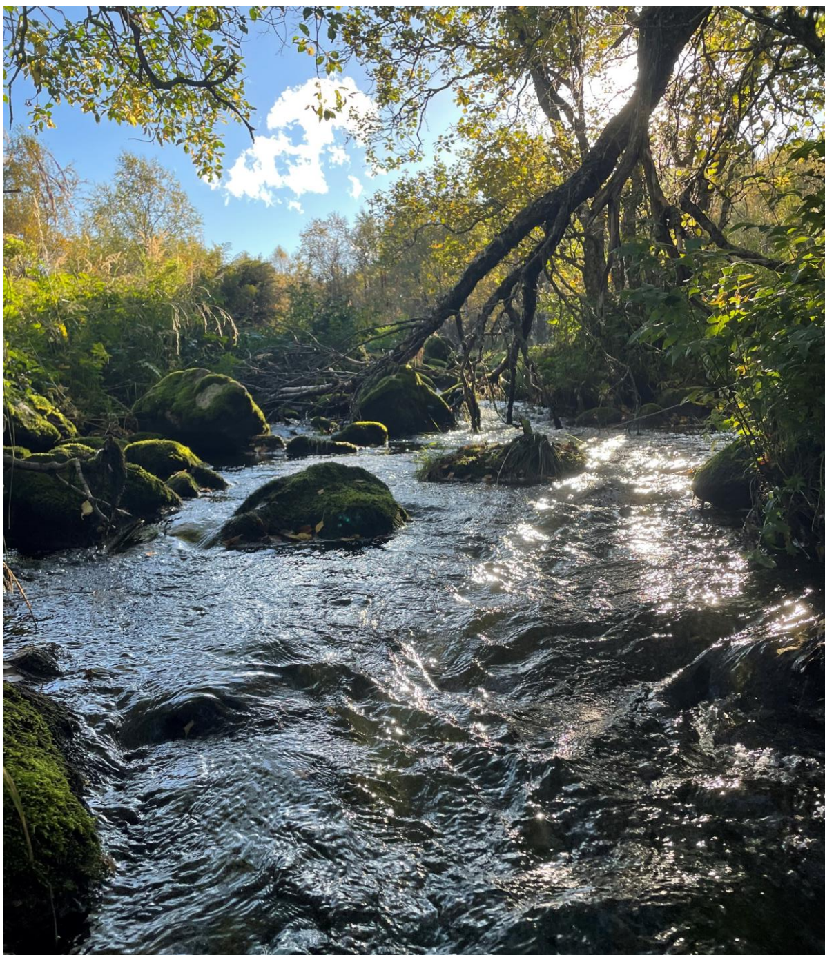
Figur 30 Fiskepassasje over Mølledammen, tillaget 2023 og utformet som naturtypisk trinn-kulp kaskade. Fisk kan nå vandre fritt.
