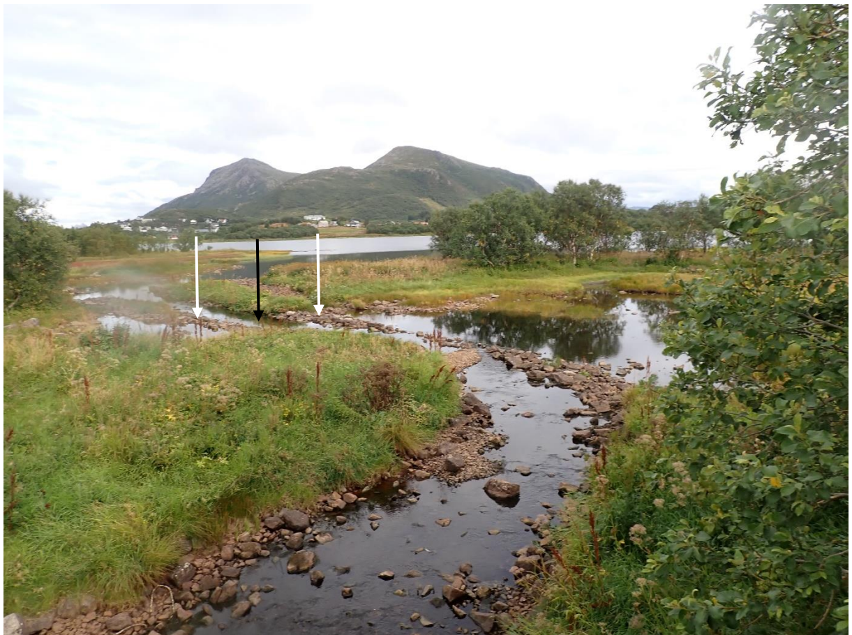
Figur 5. Teinvalen sett fra Bøveien opp mot Saltvatnet. Pilene viser grøften (svart) og voller (hvit)
